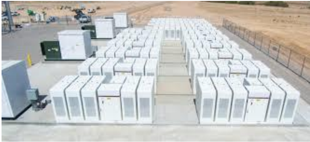
Almacenaje de energía
